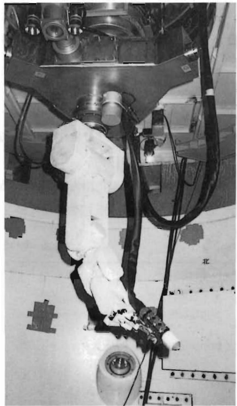
写真4 JPDR炉内構造物切断に使用したロボットマニピュレータ装置 (先端にプラズマアークトーチを把持)
